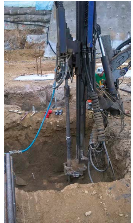
Fig. 1. Application as micropile: DYWI® Drill Hollow Bars support a construction excavation (photo: DSI Underground) Bild 1. Einsatz als Mikropfahl: DYWI® Drill Hohlstäbe sichern eine Baugrube (Foto: DSI Underground)
